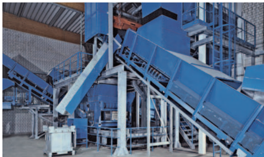
Innovative Aufbereitungstechnik: Die gebrauchten Metallverpackungen werden in einem mehrstufigen Prozess gereinigt und in leistungsstarken Spezialanlagen aufbereitet.
