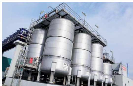
Die Lagerkapazität der SAVA reicht aus, um den Betrieb der Verbrennungsanlage fünf Tage sicherzustellen
