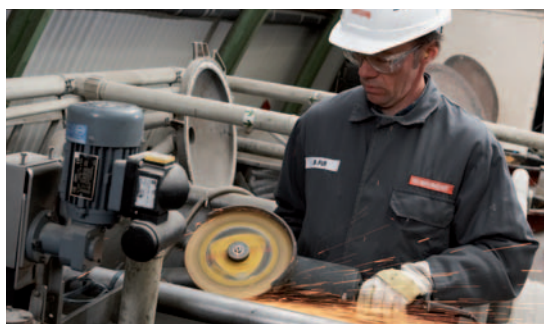
Sie arbeiten mit Gefahrstoffen? Kein Problem. Wir verfügen über das Know-how und die Technik, um Ihre Anlagen sachgerecht und schnell zu reinigen und komplett zu demontieren.
