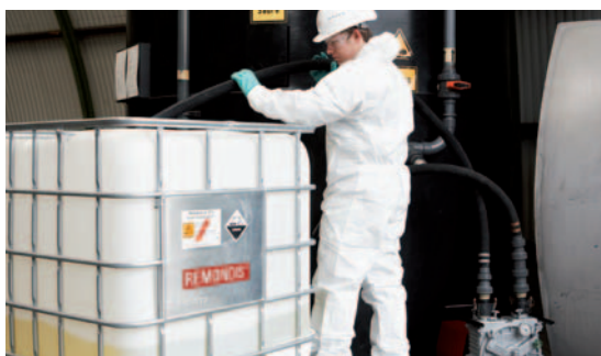
Vor Beginn der Reinigung beziehungsweise Demontage werden die noch enthaltenen Gefahrstoffe abgesaugt.
